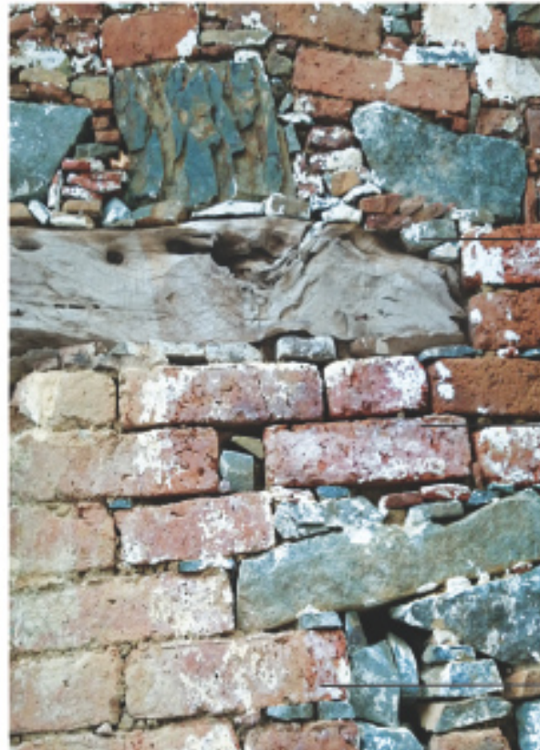
ξύλο οριζόντια τοποθετημένο
