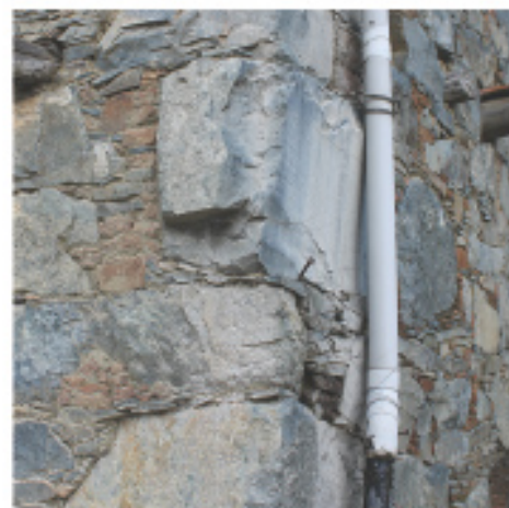
Σύνδεση τοίχων - εγκάρσια τοποθετημένες πέτρες
