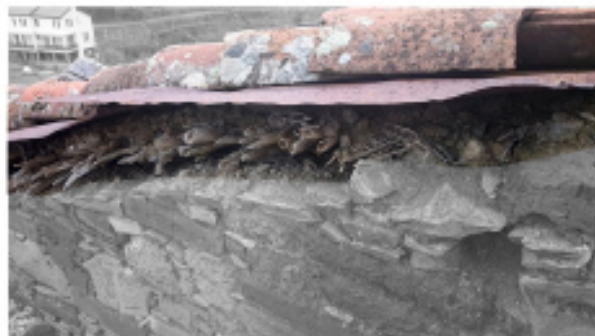
Εξωτερική όψη στέγη όπου είναι εμφανή τα κεραμίδια το χύμα και τα καλάμια
