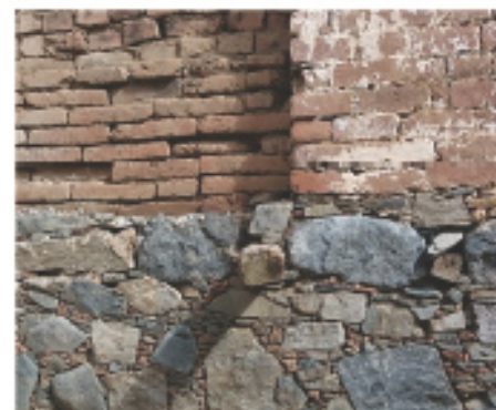
Συνόπαρξη τοιχοποιίας διαφορετικής υλικότητας. Μέσω της υλικότητας του τοίχου είναι διακριτή η χρονολογική διαφορά οικοδόμησης των δύο τοίχων.
